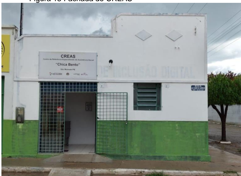
Figura 15 Fachada do CREAS
